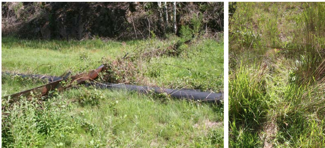
Figure 17 : barrière à amphibiens envahie par les ronciers (à gauche) et déchirée par le passage d'un petit mammifère (à droite) (Source : C. LABORDE – NEC)
