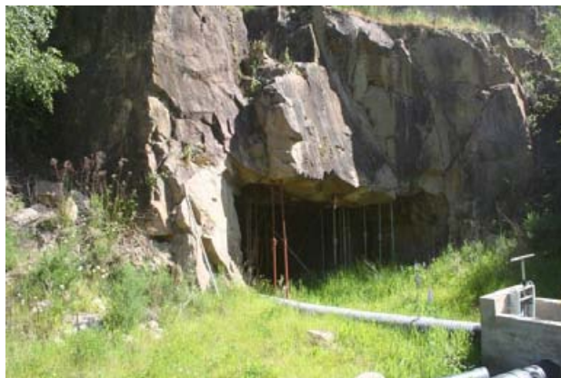
Figure 21 : photographie de l'entrée de la galerie TB 100 en juin 2017 (Source : C. LABORDE – NEC)
