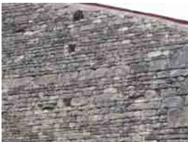
Exemple de gîtes pour les espèces anthropophiles : mur comportant des fissures et des trous.
