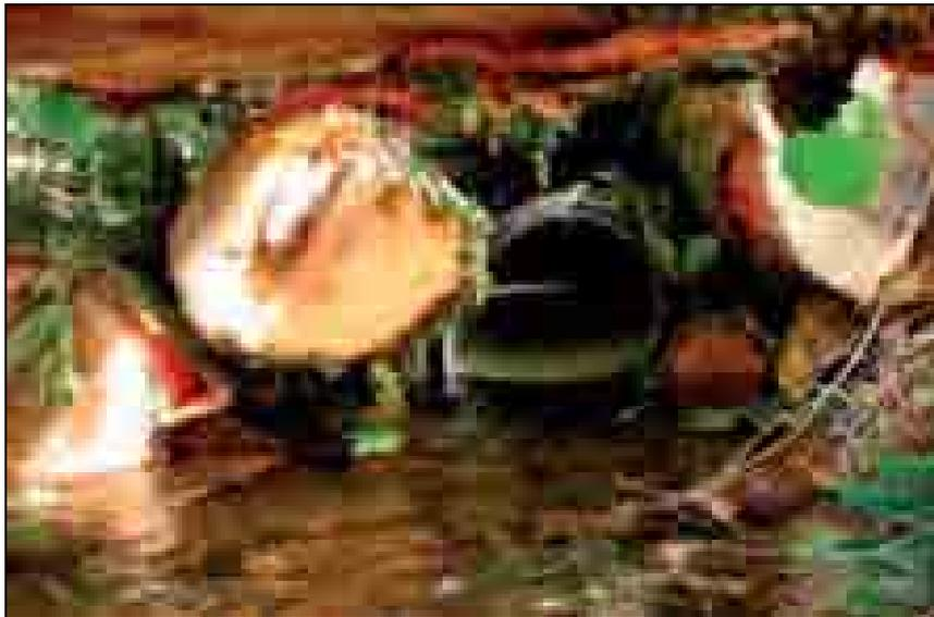
Figure n° 53 : déformation sans rupture des tuyaux PEHD (CRPF, 2006)
